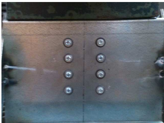
4.3 kép Z200 rögzítése a bak gerincére 8 db LD6T önfúró csavarral
