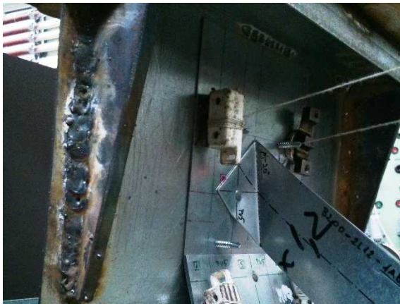
3.5 kép Z200-szelemen és bak gerincének kapcsolat a tönkremenetel után
