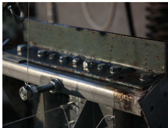
8.3 kép Z-szelemen merevítése
