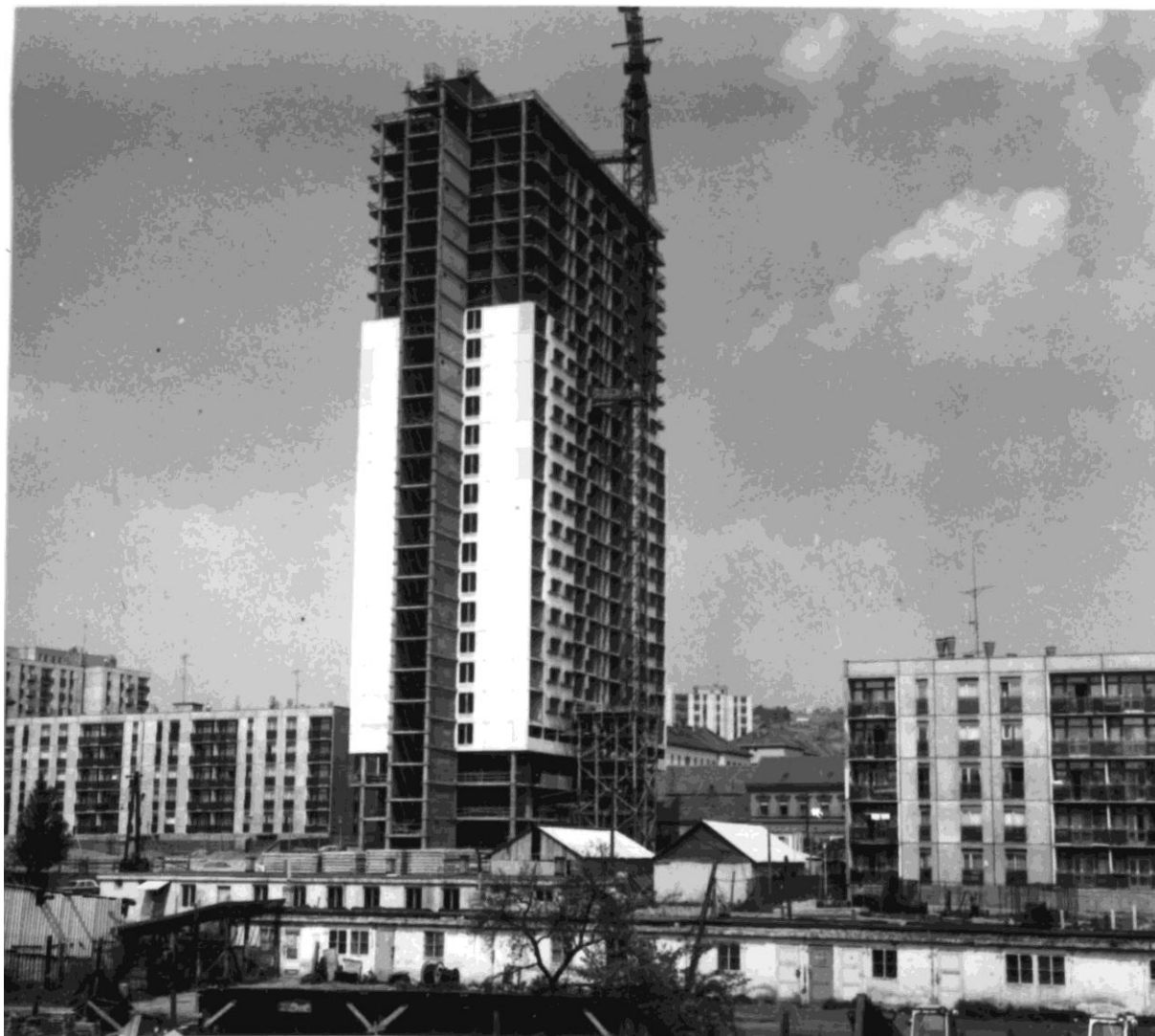
19. számú kép: A Magasház építése 2.
