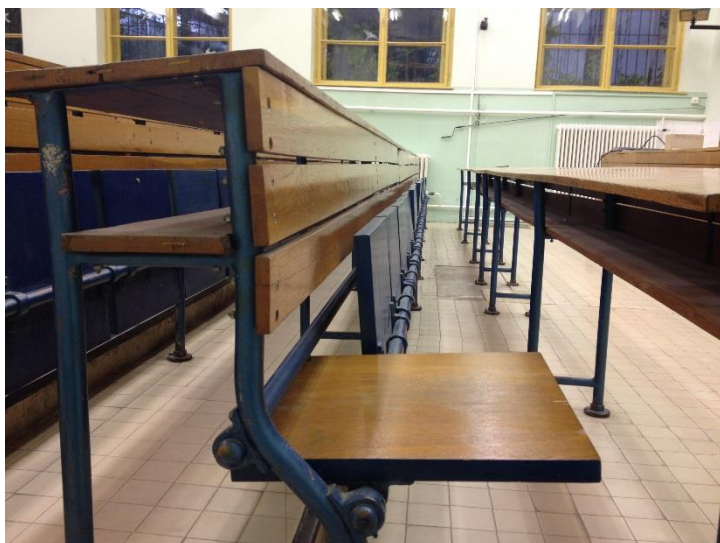
18. ábra A lehajthatós szék szerkezete
