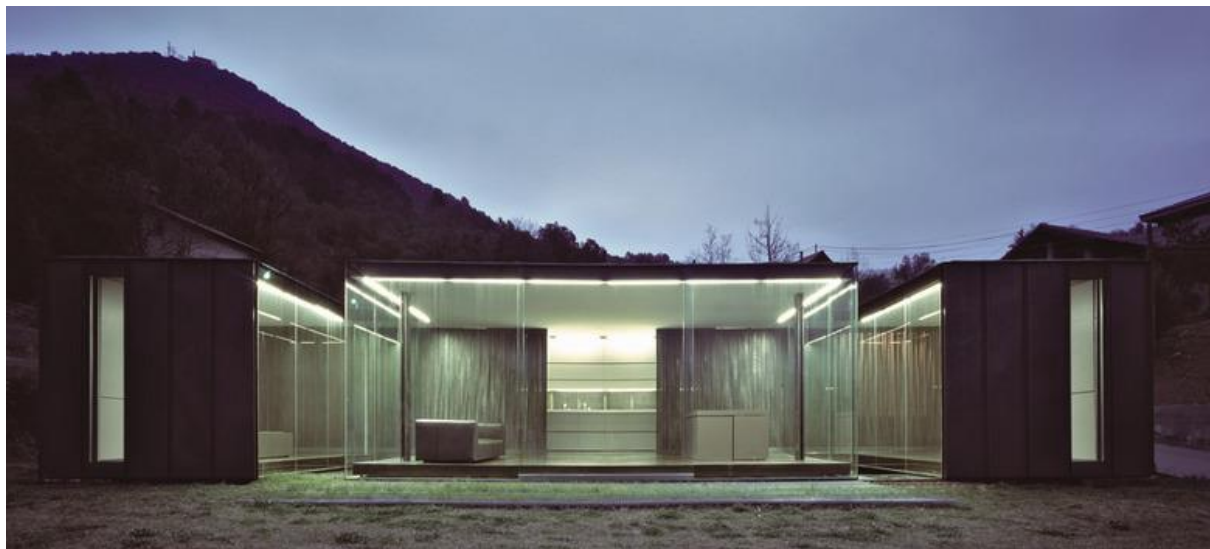
Ábra 14.-15.: RCR Arquitectes, CASA M-Lidia ,Spanyolország
