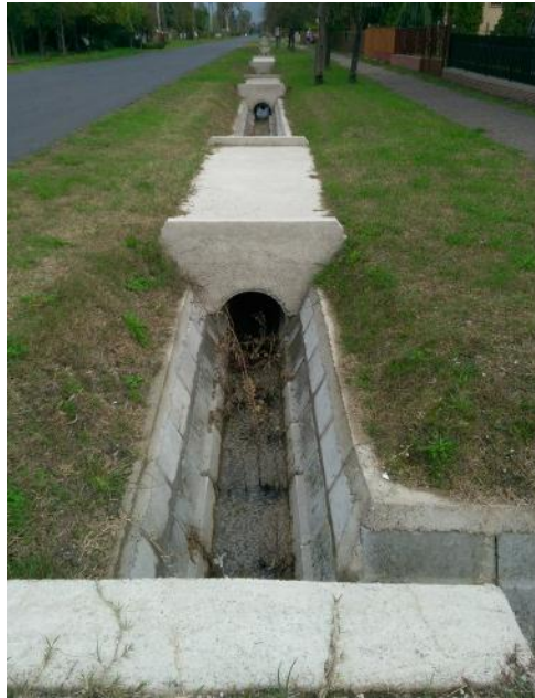
3.2. ábra. Felújított árok
