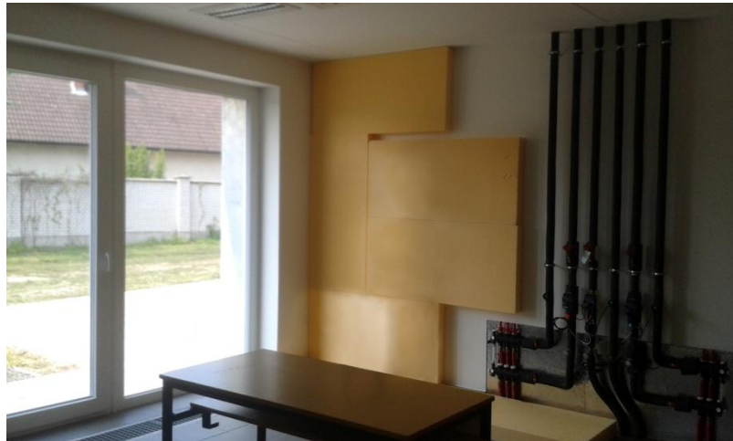
4. ábra: Hőszigetelés elhelyezése a 3-as kutatószobában
