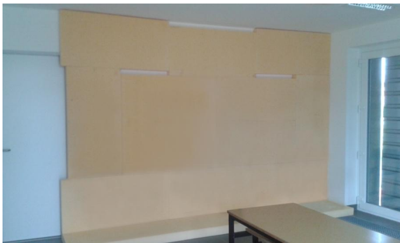
3. ábra: Hőszigetelés elhelyezése az 1-es kutatószobában
