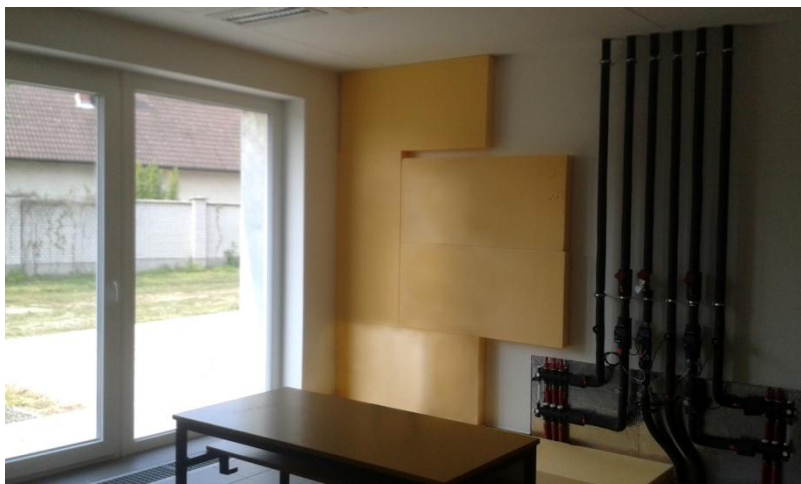
4. ábra: Hőszigetelés elhelyezése a 3-as kutatószobában
