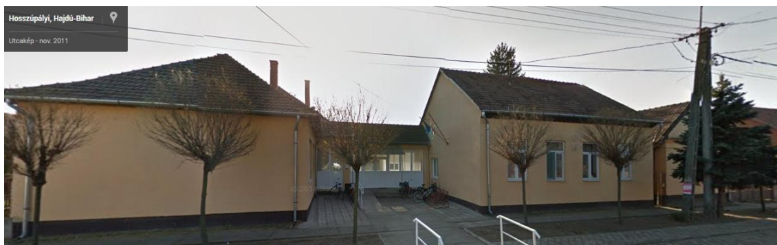
5. Ábra: Hosszúpályi Óvoda látképe II. (forrás: Google Maps)
