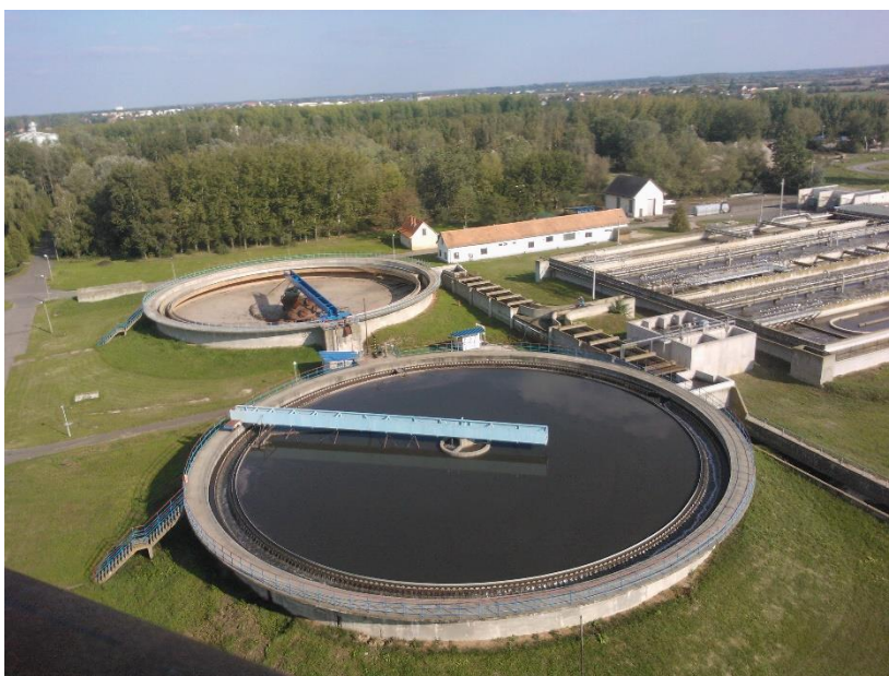
7. ábra: Debreceni szennyvíztisztító üzem [forrás: saját készítés]
