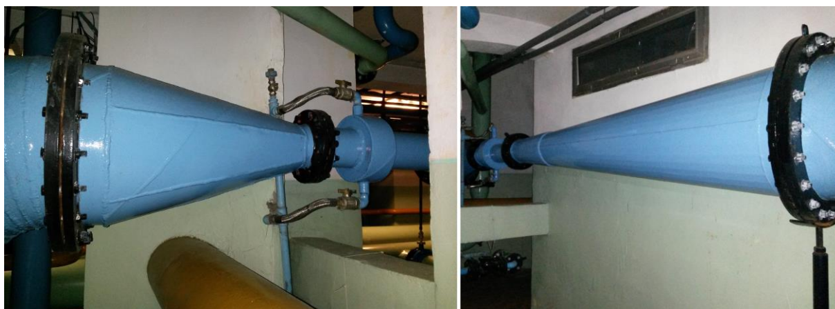
4. kép - Venturi keverőidom (2014. 11. 06.)
