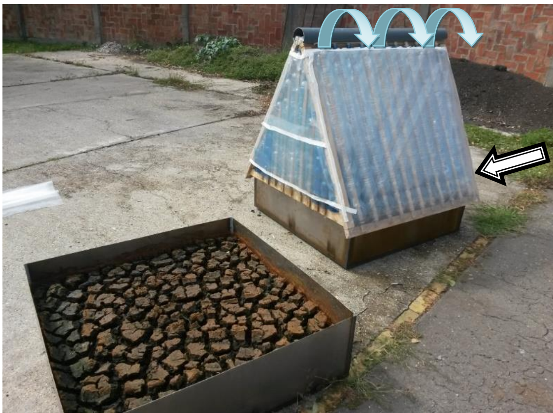
14. kép – Szolár sátor végső kialakítása (2014. 08. 25.)
