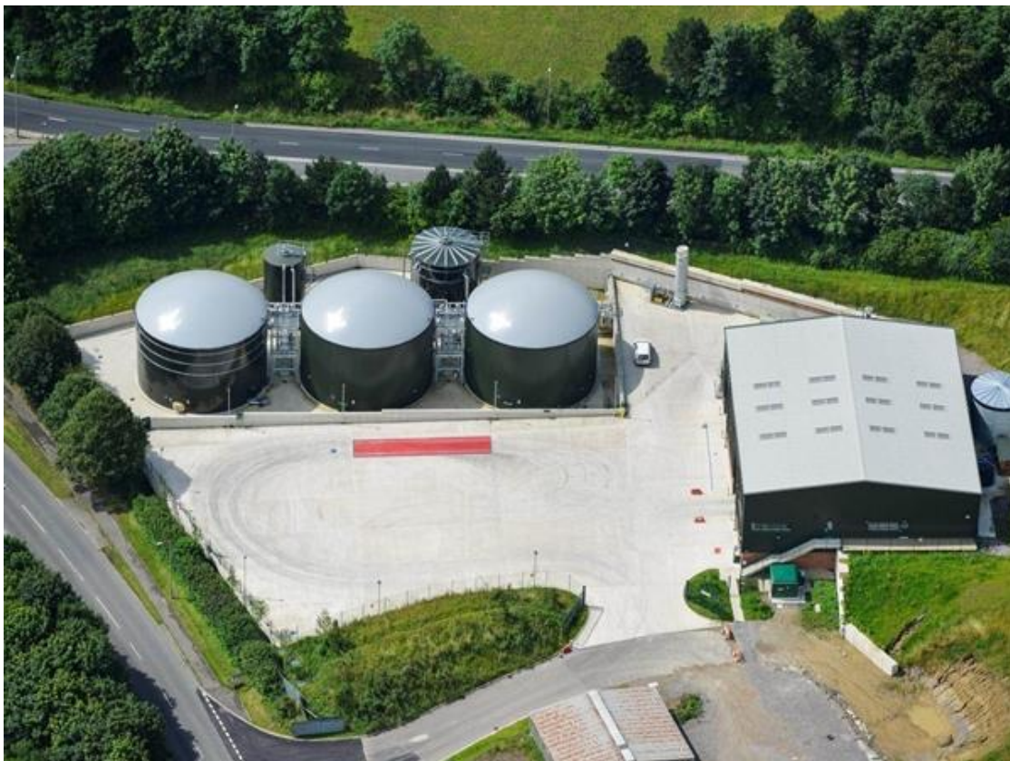
7. ábra: Biogáz előállító telep Forrás: [31]
