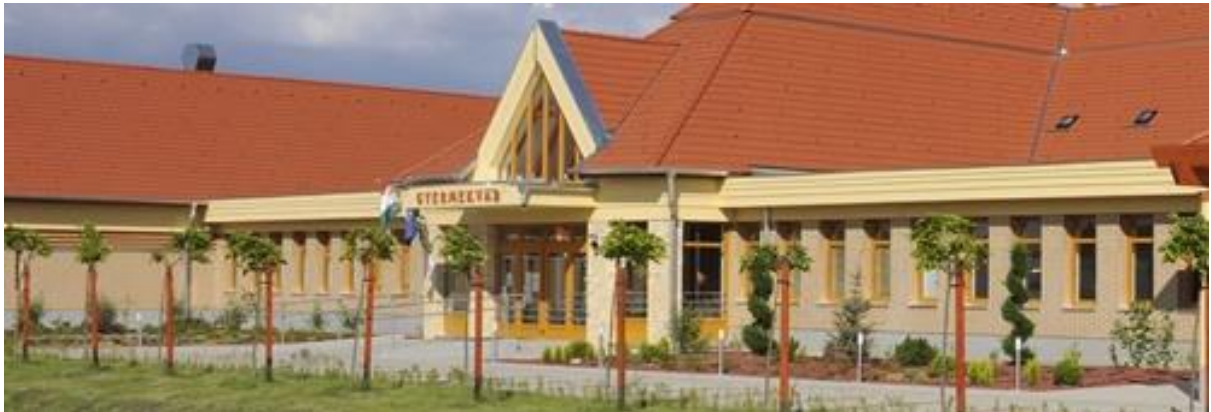
Foto 16. Hartianer Kindergarten - der Eingang
