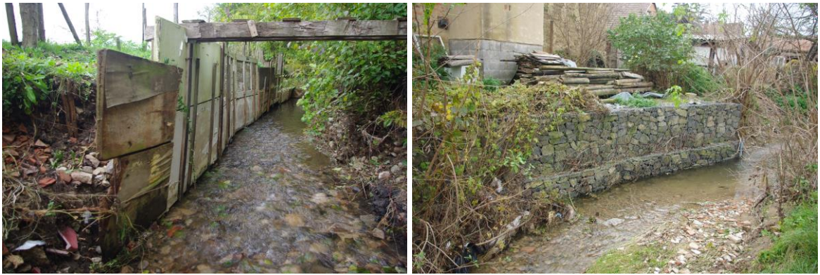
4.4-10. Kép Egyszerű házi módszerrel stabilizált partoldal és gabion kőzsákkal védett partoldal (fotó: KALMÁR P. 2014)
