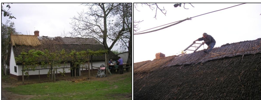
20. ábra Táskai pincesor (Szadó) a szegés felújítása, 2014. október /fotó: Marton Vince/
