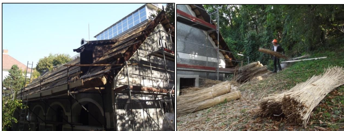
21. ábra Nádtetőkészítés napjainkban - a Bakonyi Tájháza Veszprémben /Saját fotók/
