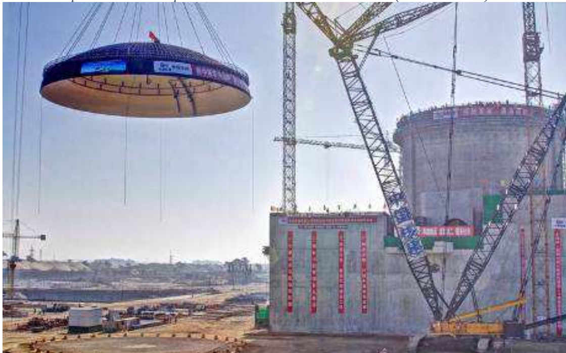
5. ábra: Kupola rátétele az építés alatt álló Kashma III reaktorra (2013. március)
