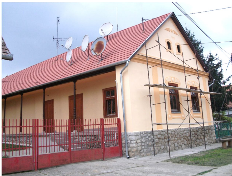
5. kép A jelenleg felújítás alatt álló nagyvejkai művelődési ház
