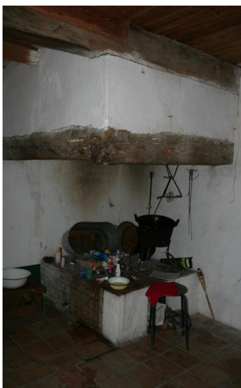
16. A préház füstfogós szabadkéménye , alatta a konyhai tűzelőberendezéssel , Limbacher Gábor felvétele
