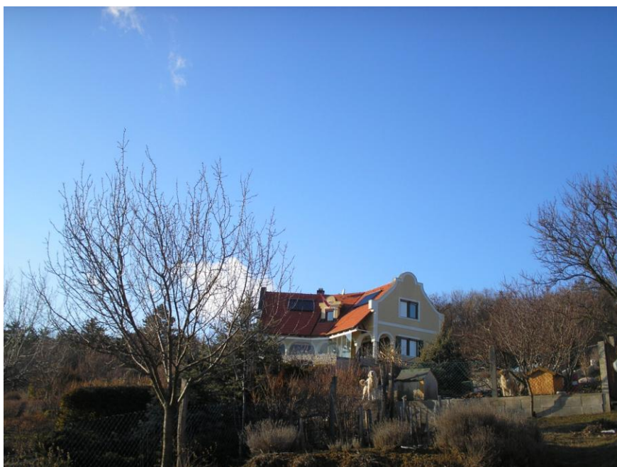
18. A gondosan körbekerített, díszkerttel övezett villa, tetején a napelemekkel
