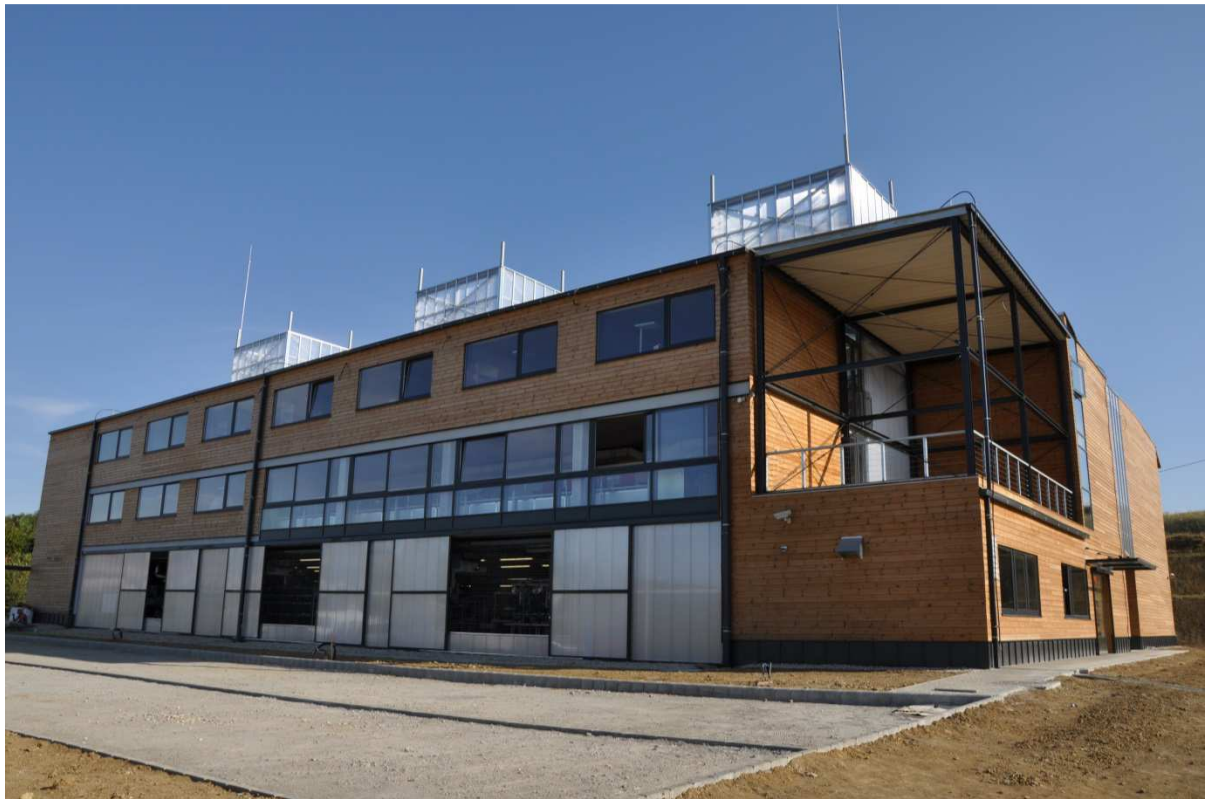
4.7. ábra: A kivitelezett kísérleti épület 3 db északi homlokzati utánáramlási kapuja (fotó az építkezésről)
