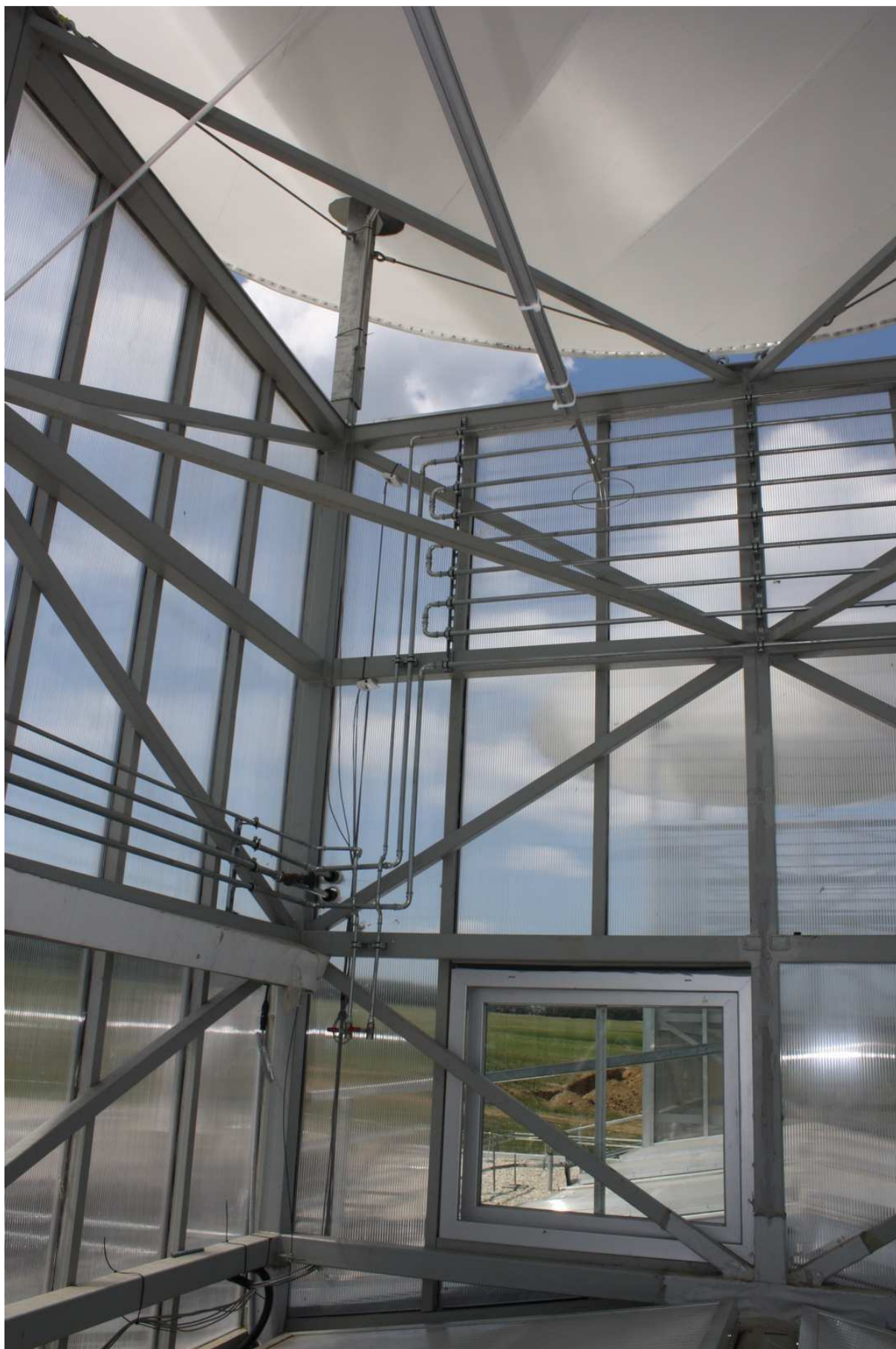
4.16. Ábra: Hódrótos anemométer szenzor a torony felső részében és a toronyfűtés hőcserélője a torony felső részében
