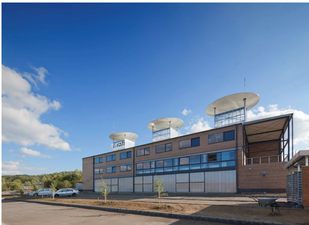
3.1. ábra: A kísérleti épület, a RATI Kft. ipari és irodaépülete passzív szellőztornyokkal. Északi homlokzat a földszinti termelőcsarnok polikarbonát külső falával és 3 db kapuval
