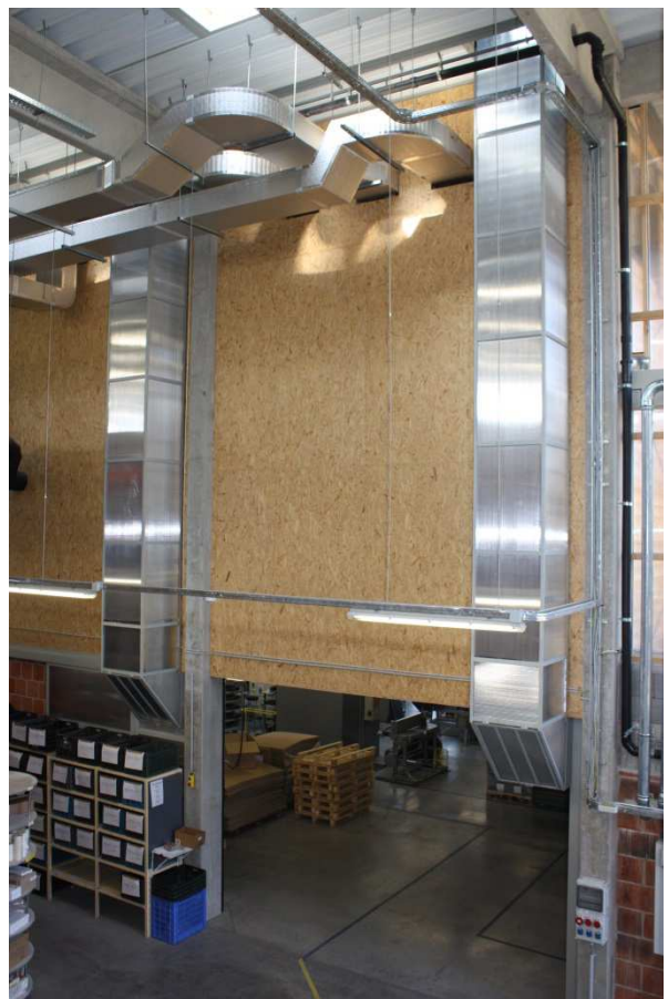
4.9. ábra: A termelőcsarnok nyugati szellőztetőtornya közös légtér a termelőcsarnokkal (balra), a keleti szekcionált kapu a raktárcsarnok és a gyártócsarnok között
