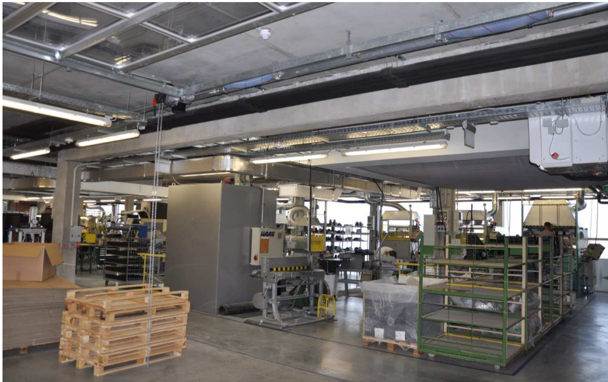
4.11. ábra: A földszinti gyártócsarnok a termelés technológiai berendezéseivel
