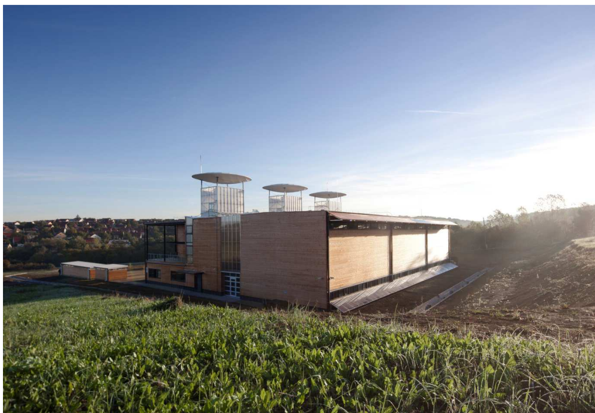
1.1. ábra: Kísérleti épület, a RATI Kft. ipari és irodaépülete passzív szellőzőtornyokkal
