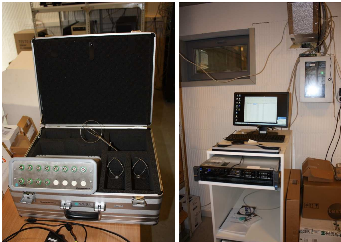
4.18. ábra: Az MMS épületmonitoring rendszer szerver PC (jobbra), anemométeres mérésadatgyűjtő Mini CTA (balra)
