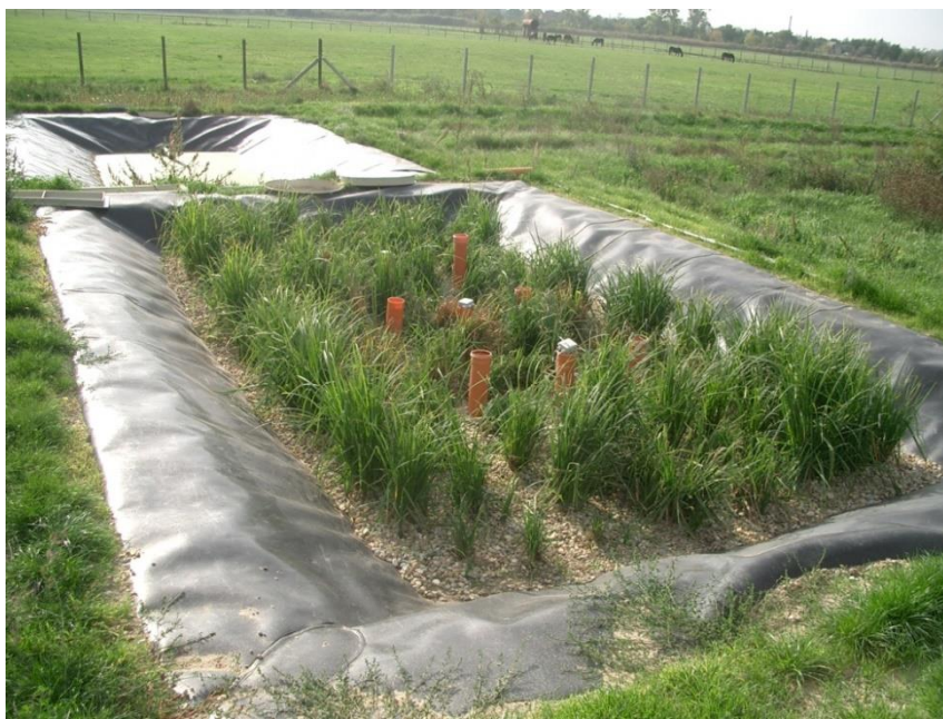
1. ábra A hosszanti átfolyású gyökérvénás műtárgy (fotó: Dittrich Ernő 2007.10.07.)
