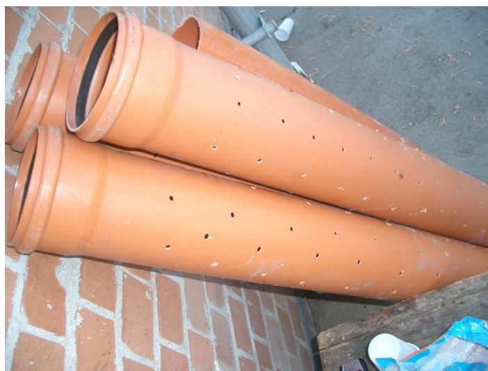
2. ábra A beépítésre előkészített perforált csövek (fotó: Dittrich Ernő (2007.07.17.)
