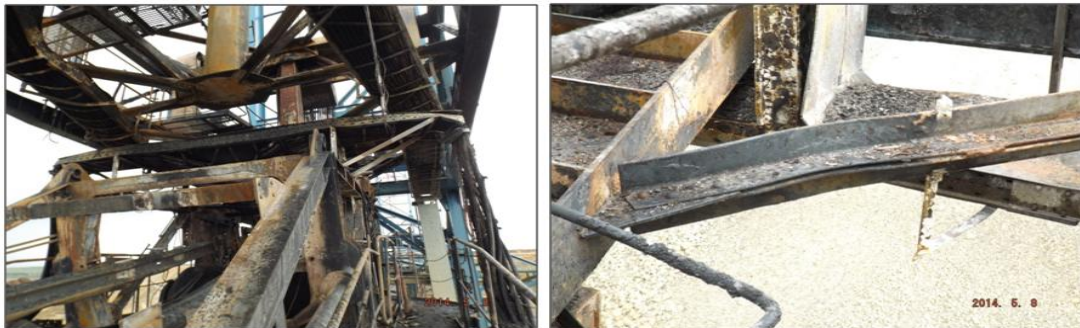
20. ábra Baloldali képen a köztiszalag fejrésze, míg a jobboldalt egy szélrács deformációja látható
