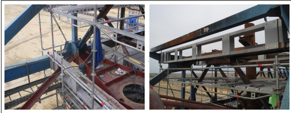
31. ábra Baloldali képen az alsó, míg a jobboldali képen a felső síkon elhelyezett szerelőgerendák láthatók
