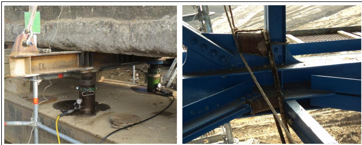
39. ábra Baloldalt a keresztartó alatt elhelyezett hidraulikus sajtók, míg jobboldalt az alsó főtartón átdobott egyik kötélág látható
