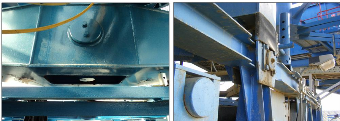
18. ábra Baloldali képen az y tengely körüli elfordulást, míg a jobboldali képen az x tengely körüli elfordulást biztosító csukló
