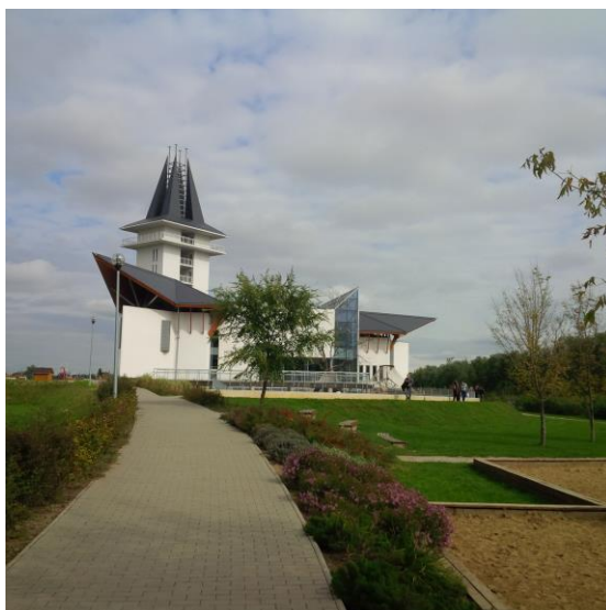
5. kép Az Ökocentrum főépülete Forrás: Saját készítés
