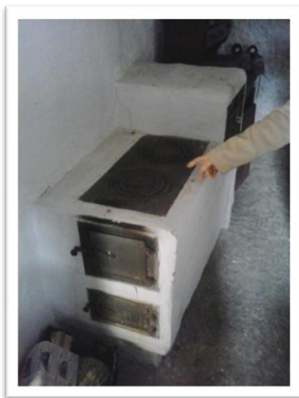
24. Felújított rakott tűzhely
