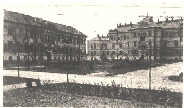
7. kép A Főépület és a Sebészet épülete az udvarról nézve
