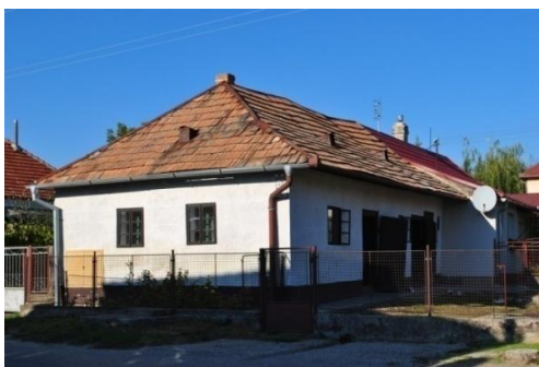
9. ábra: Vályogtéglából épült földszintes ház (Forrás: Saját kép)
