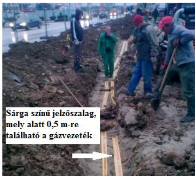
3. ábra, Jelzőszalag elhelyezése a munkaárokba Forrás: http://www.unigeokft.com/koezmepites Letöltés ideje: 2014.10.28 11:41 Szerkesztve: a szerző
