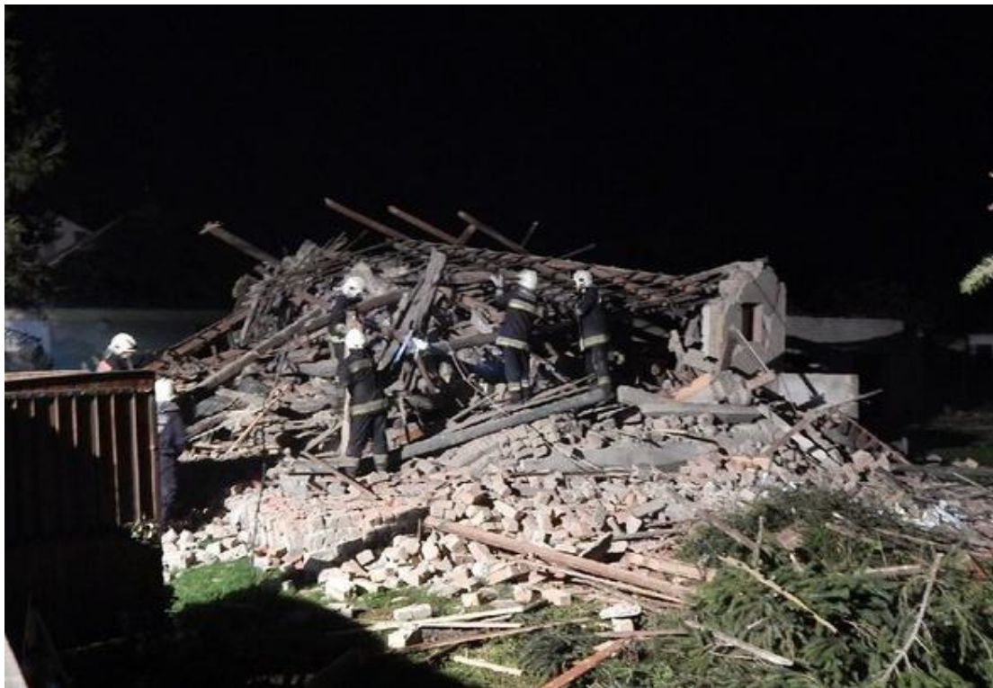
38. ábra. Gázrobbanás utáni állapotok, Forrás: http://www.delmagyar.hu/kepek/gazrobbanas_bosarkanyban_-_fotok_cskovacs_attila/2040073/2972663/ Letöltés ideje: 2014.11.05 20:02
