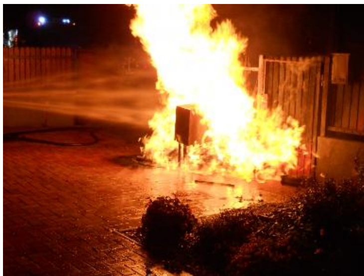
29. ábra. Kisméretű fáklyaégés, fogyasztói gázvezetéken. Forrás: http://www.sarospatak.hu/kepek/11jul_gazfaklya.jpg Letöltés ideje: 2014.10.28 14:31
