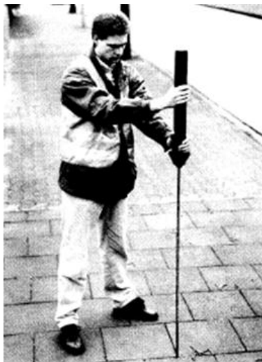
16. ábr: Szondafúró használata, Forrás: E.ON Tűzmentani modul ppt.
