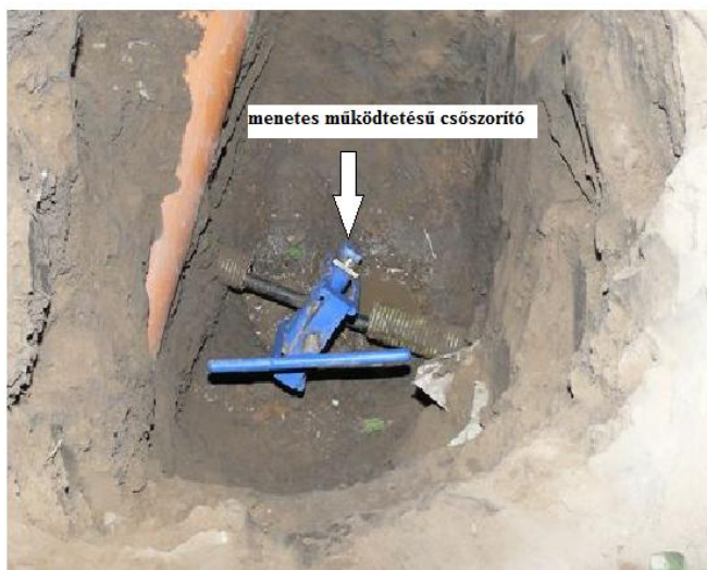
26. ábra. Nem rendszeresített menetes és hidraulikus csőszorító,
