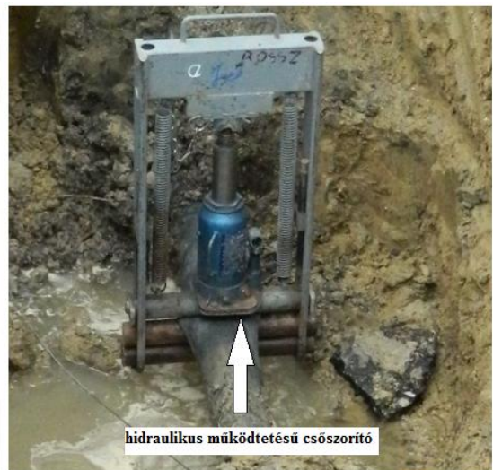
26. ábra. Nem rendszeresített menetes és hidraulikus csőszorító,
