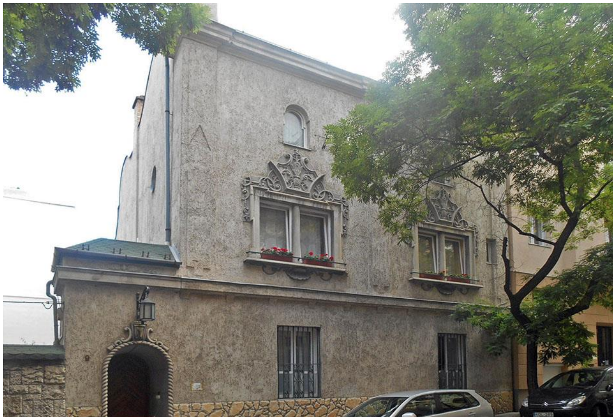
20. sz. kép A ház főhomlokzata
