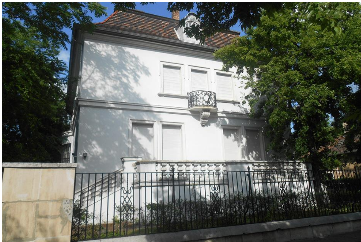
17. sz. kép A ház főhomlokzata
