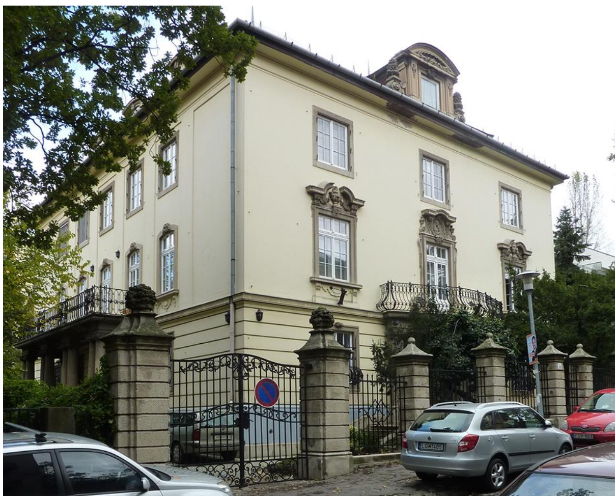
26. sz. kép A ház főhomlokzata
