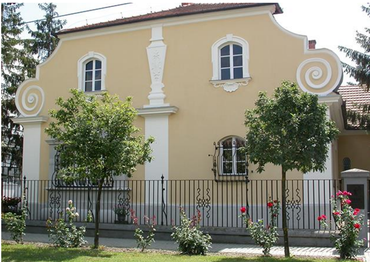
24. sz. kép A ház főhomlokzata
