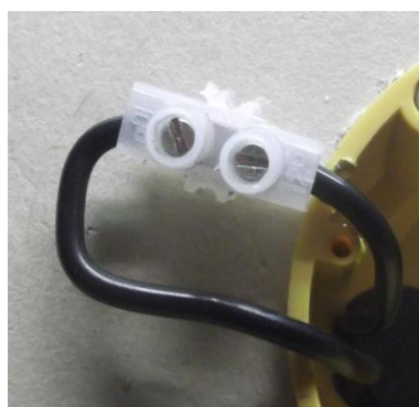
37. ábra Sorkapocsos kötés 2,5 mm 2 alumínium vezetékekkel
