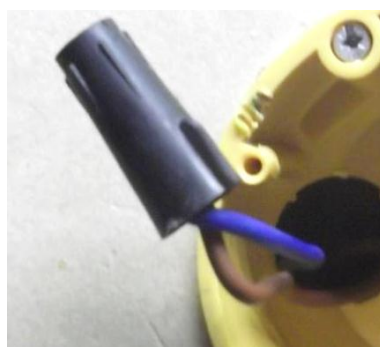
34. ábra Kupolfix kötés 1,5 mm 2 réz vezetékekkel
