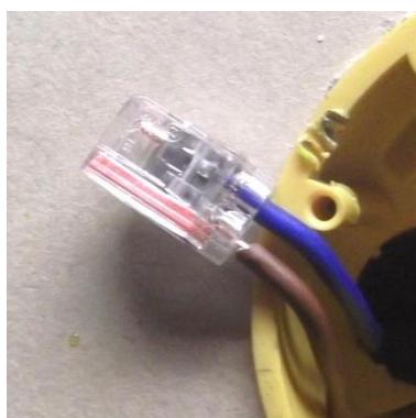
32. ábra Laprugós kötőelemmel ellátott kötés 1,5 mm 2 réz vezetékekkel
