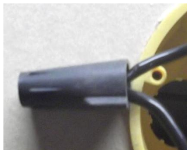
20. ábra Kupolfix kötés 1,5 mm 2 alumínium vezetékekkel
