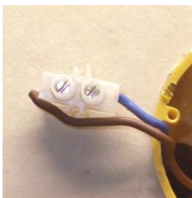
39. ábra Sorkapcsos kötés 1,5 mm 2 réz vezetékekkel
