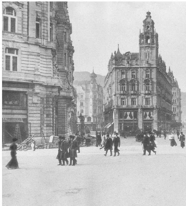
10. „Az 1902-ben épült Klotild paloták a Kígyó, illetve az Eskü út sarkán. Háttérben az épülő Erzsébet híd.”
