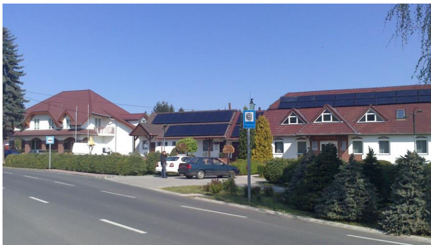
5. kép: Balra az új Apartmanház, jobbra az IKSZT-ként működő Községi Ház
