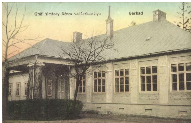
28. kép: Az átalakított homlokzat
