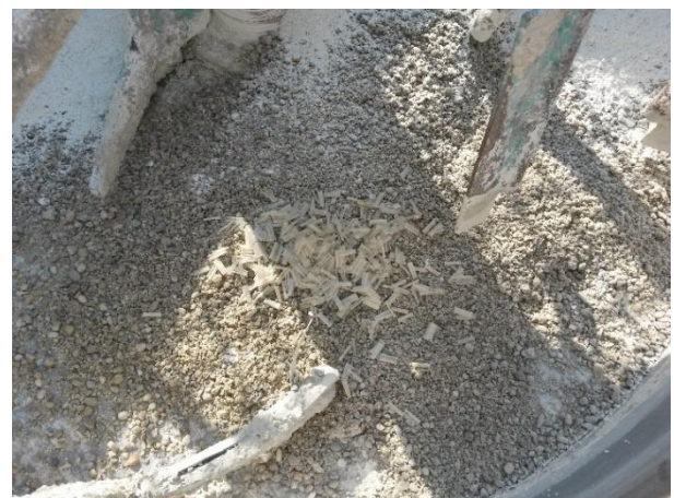
42. ábra: Műanyag szálak adagolása a betonba
