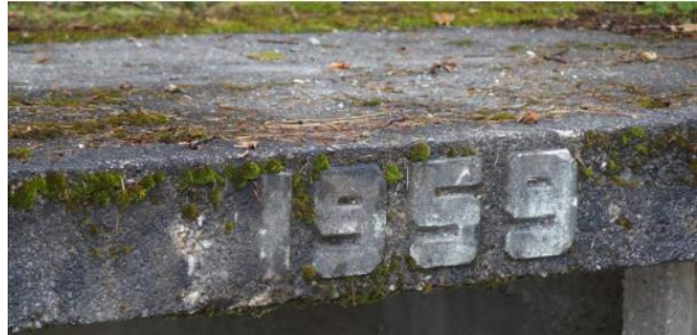
2. ábra: Múlt századi látszóbeton [4]
