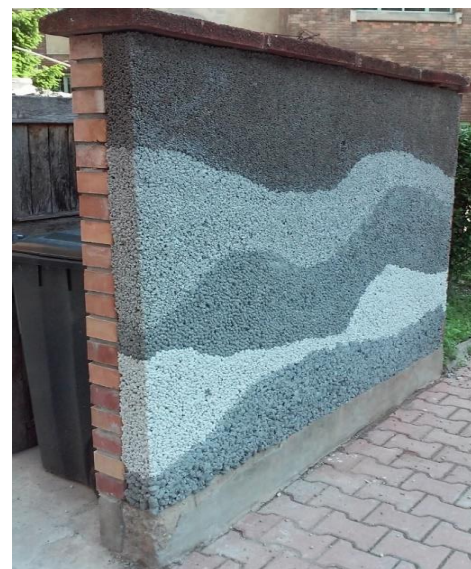
7. ábra: Szemcsehézagos látszóbeton fal
