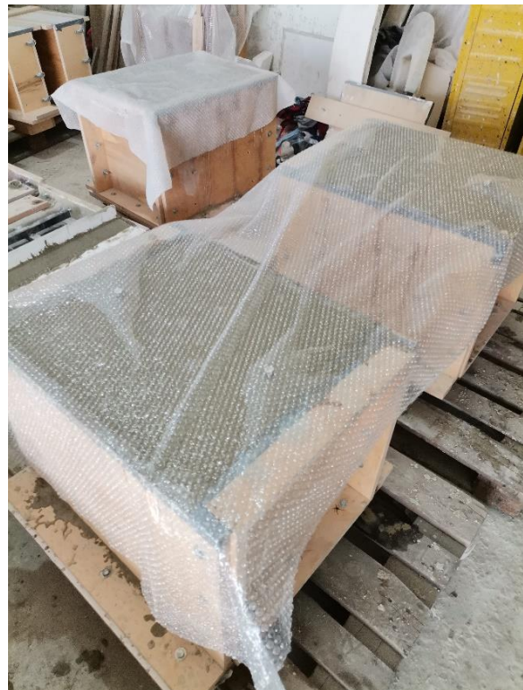
29. ábra: Beton utókezelése
