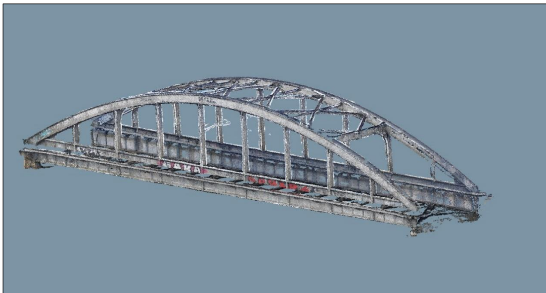
28. Ábra WebODM, mobiltelefon, színezett pontfelhő
