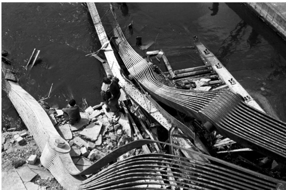
3.15. ábra: Elhajlott láncköteg a Dunában [19].
