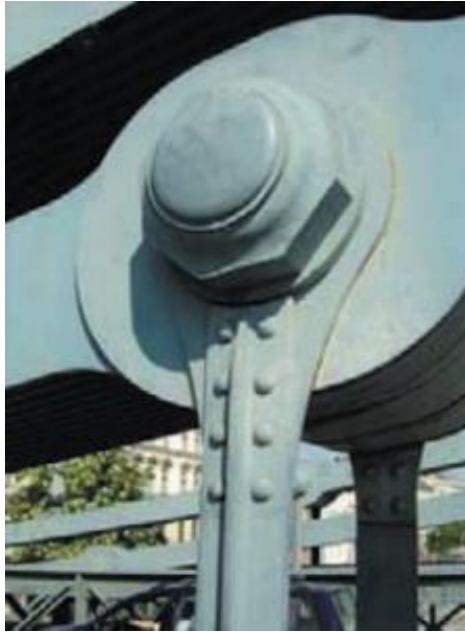
4.2. ábra: A függesztőrúd és láncköteg kapcsolata [1].
