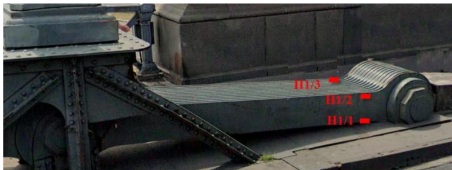
5.6. ábra: Nyúlásmérő belyegek elhelyezkedése az iránytörő saruk mellett.
