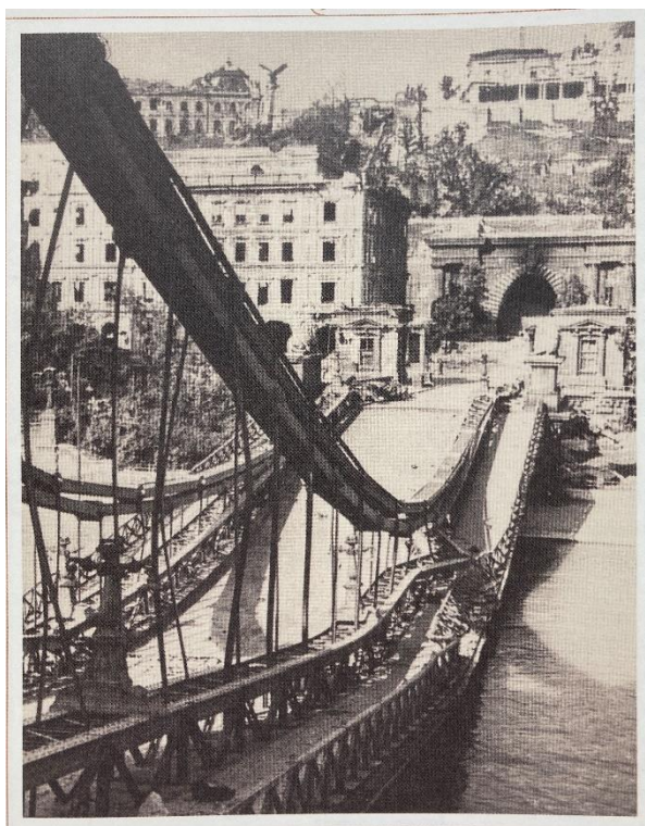
3.14. ábra: A budai nyílás kettőtört pályalemeze [6].
