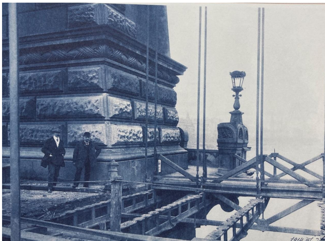
3.6. ábra: Az 1849-es szerkezet fa járdája és faszerkezetű merevítőtartója [6].
