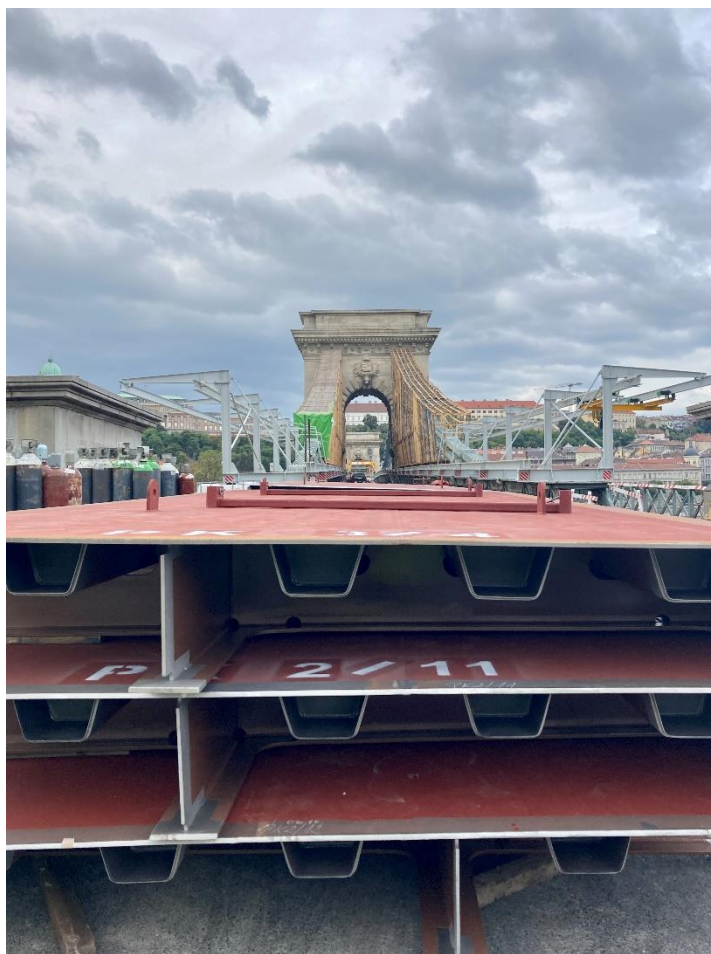
4.4. ábra: Új ortotrop pályalemezek az építkezés helyszínén.
