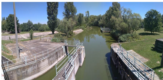
2.3.5.2. ábra: A 4T műtárgy, balra a hallépcső
