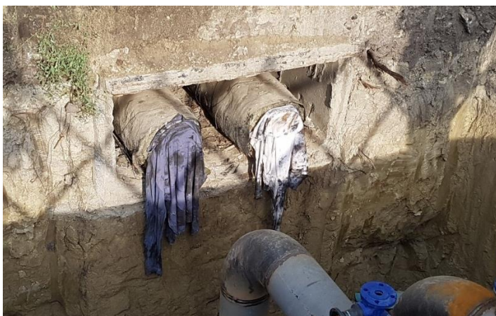
6. ábra: Szakasz kiváltáskor megbontott régi, betoncsőben vezetett távvezeték
