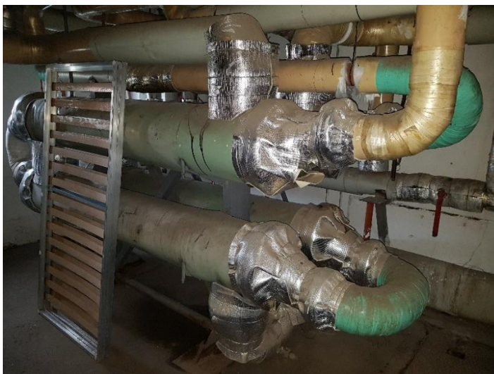
5. ábra: Szobaméretű csőköteges hőcserélő egy komáromi hőközpontban
