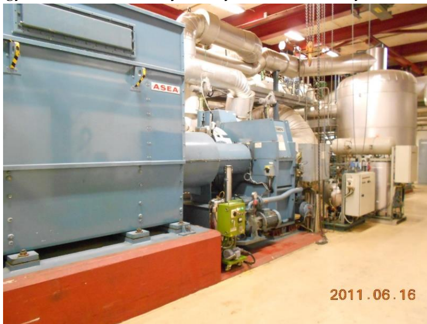
3. ábra: Hőszivattyú. Forrás: Lund's Energy
