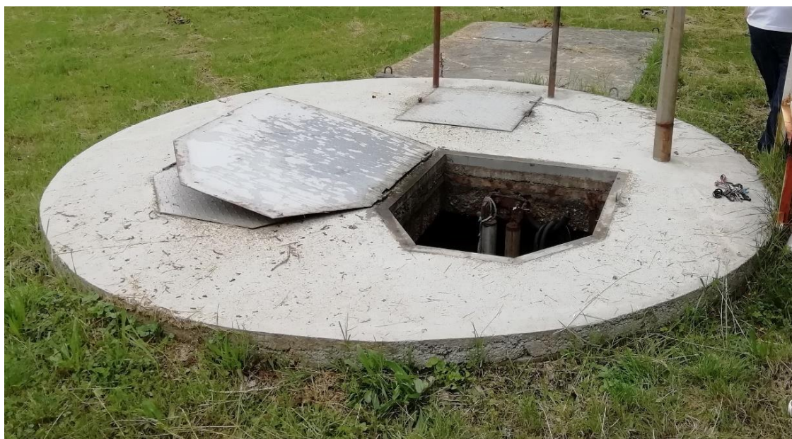
20. ábra: Beton gyűjtőakna
