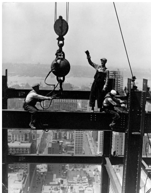
1. ábra New York-i felhőkarcoló acélszerkezetén dolgozó munkások [2]
