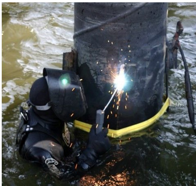
1.1. ábra. Helyszíni hegesztés extrém körülmények közt 1
