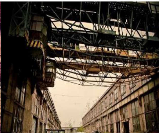
24. ábra Közműátvezetések a magasban
