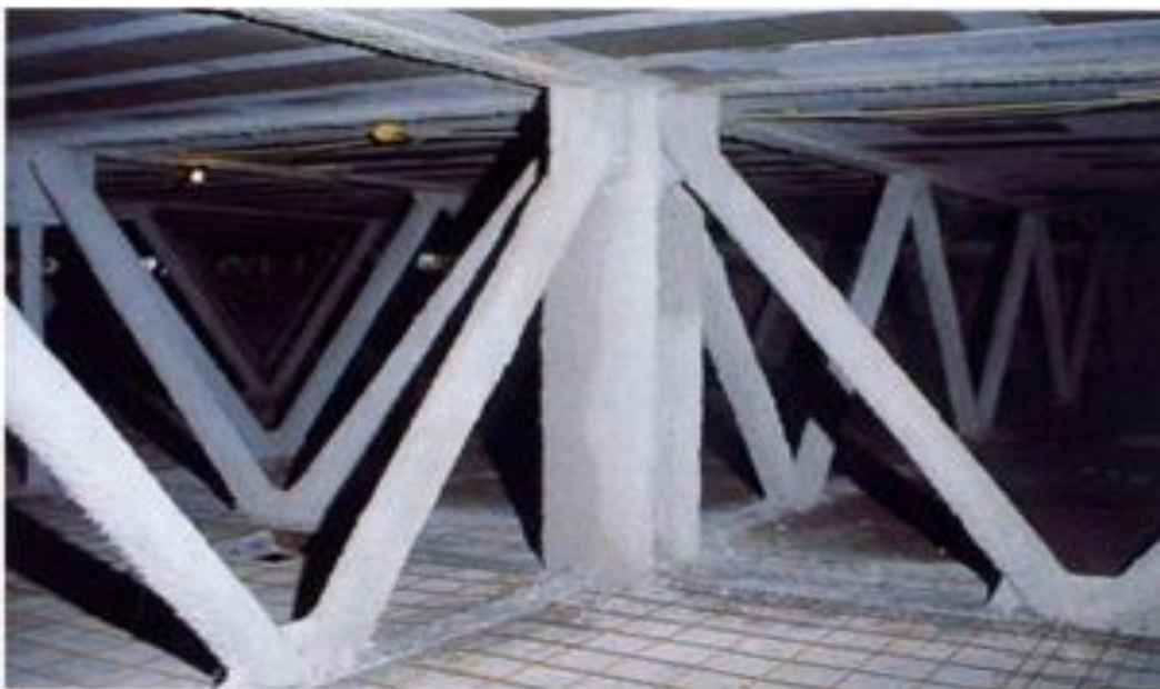
27. ábra Acélszerkezet szórt ásványgyapot tűzgátló védelme
