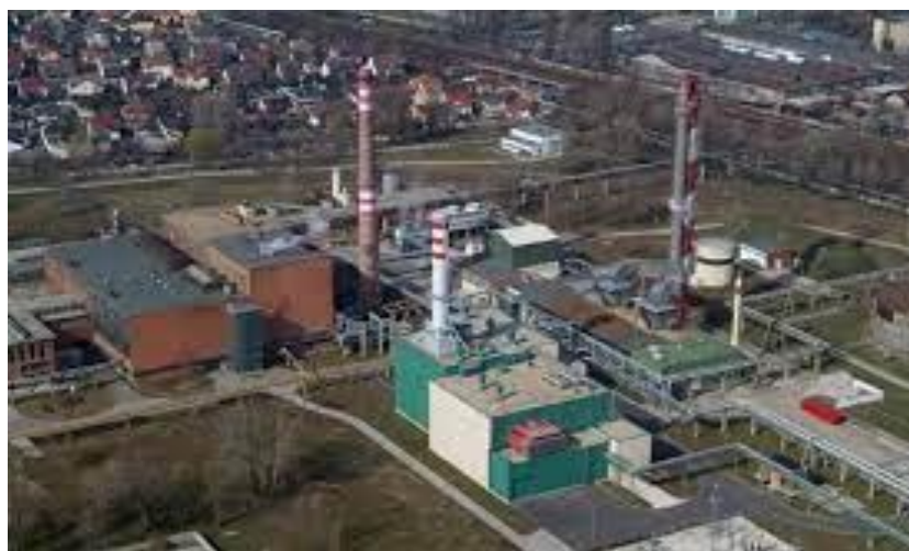
7. ábra Kispesti Erőmű hibrid építészeti megoldás
