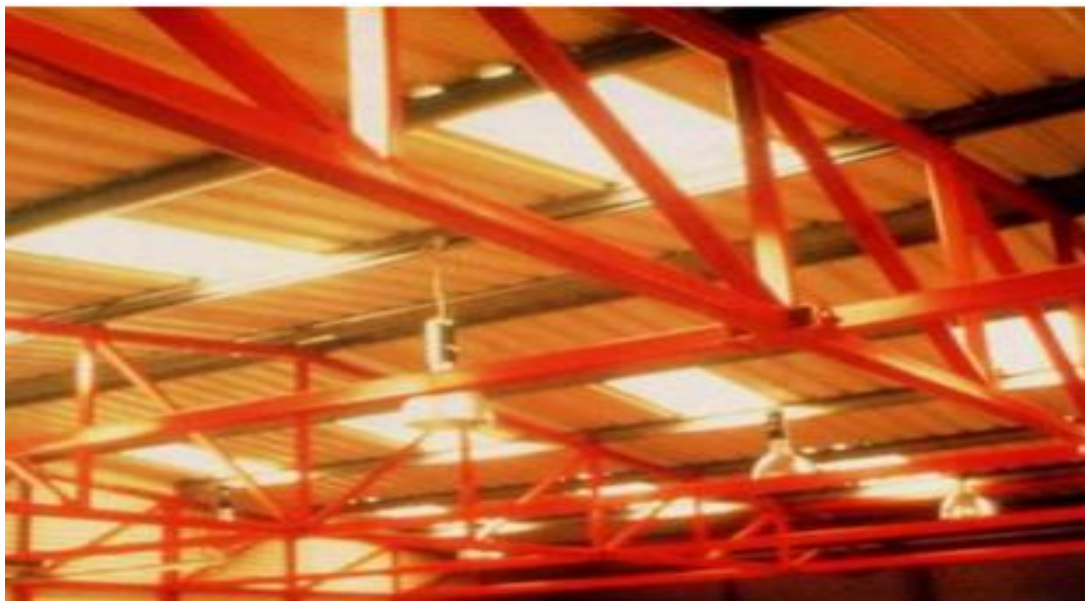
26. ábra Acélszerkezet tűzgátló festése
