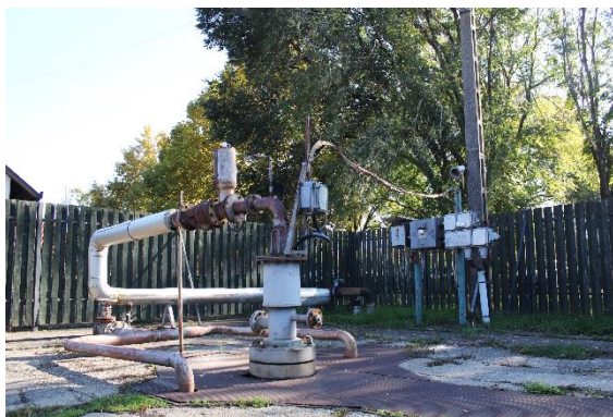
20. ábra: A kettős kiképzésűnek indult Mátyás utcai termelőkút, két oldalán a nem üzemelő visszasajtolókút
