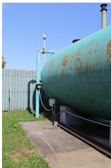
24. ábra: II. Számú visszasajtoló kútnál lévő puffertartály
