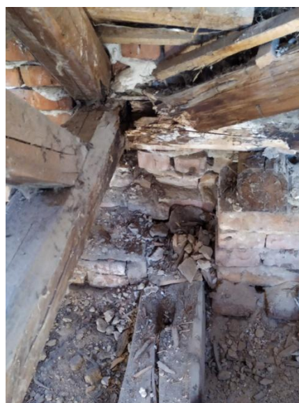
1. ábra Biológiai károsodások (rovarrágások, beázások okozta korhadás)
