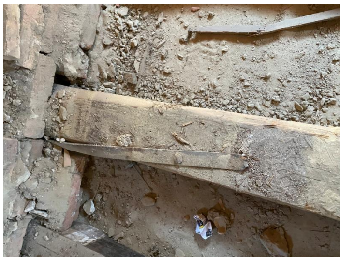
4. ábra Födémgerendába rögzített vaskapocs
