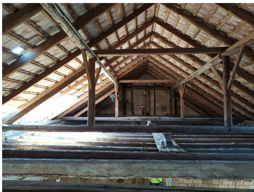
2. ábra Feltárt födém- és tetőszervezet
