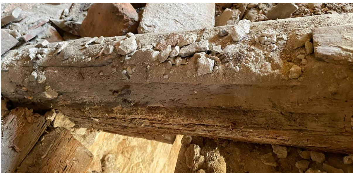
7. ábra Vaskapocs nagymértékben károsodott gerendavégben
