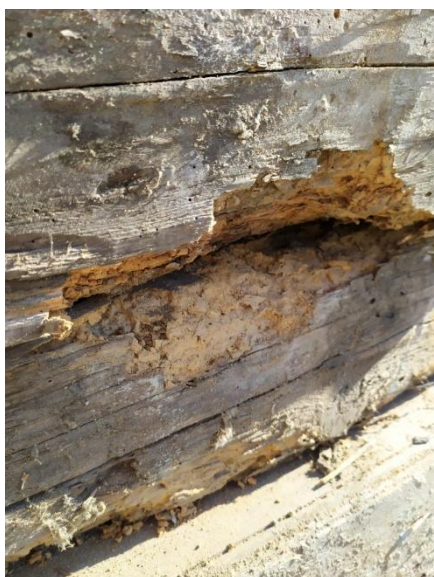
1. ábra Biológiai károsodások (rovarrágások, beázások okozta korhadás)
