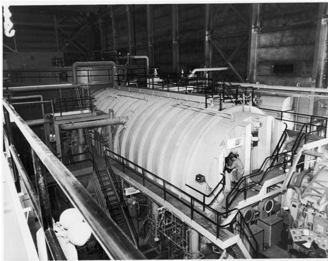
[7.kép] A USS Nautilus S1W reaktora
