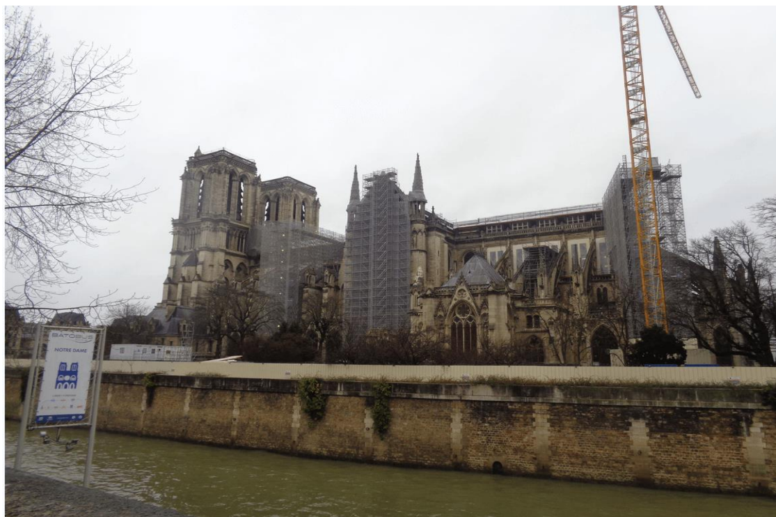
10. ábra A felújítási munkálatok, készítette: a szerző 2021.12.19. 12:17
