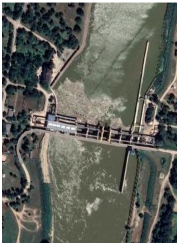
3.2. ábra. Kiskörei vízerőmű. Forrás: Google Earth
