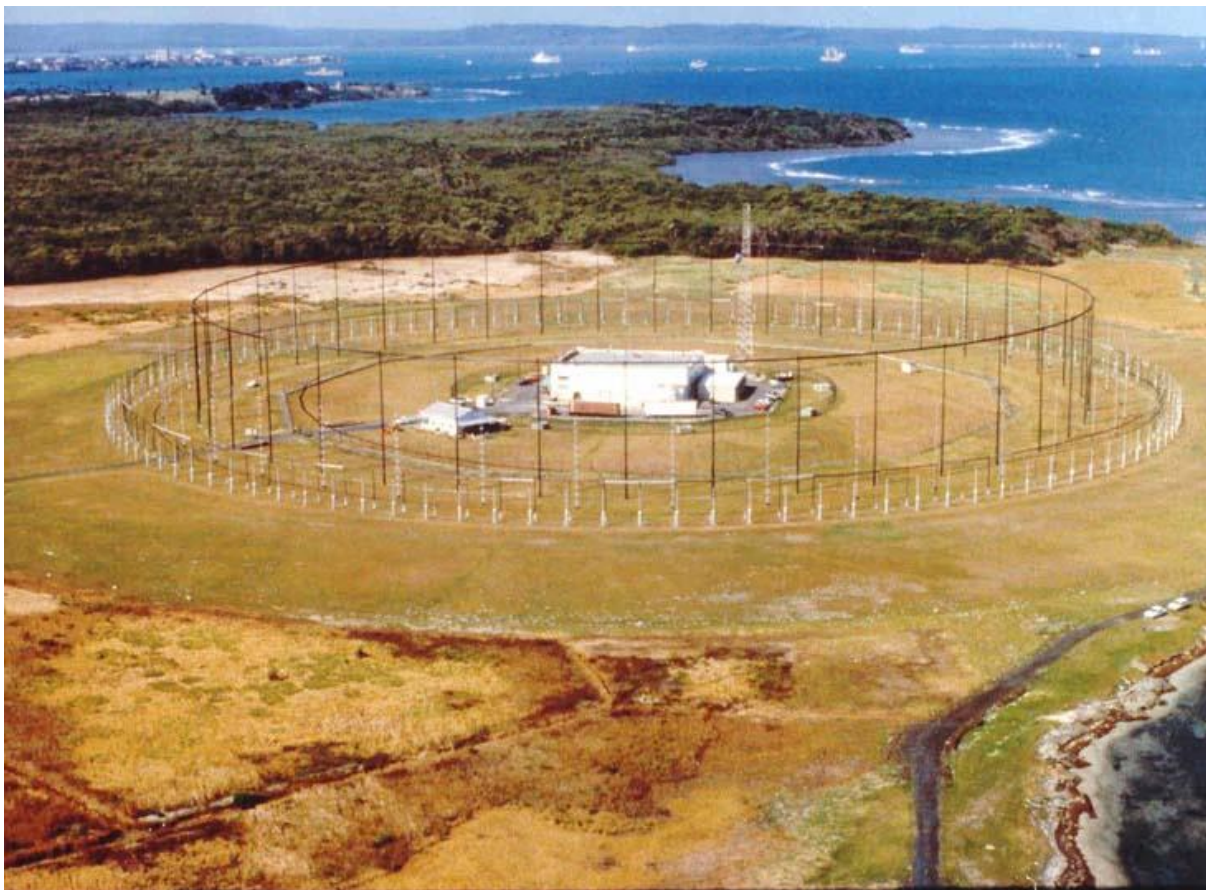
16. ábra Példa CDAA/Wullenweber antennarendszerre 37
