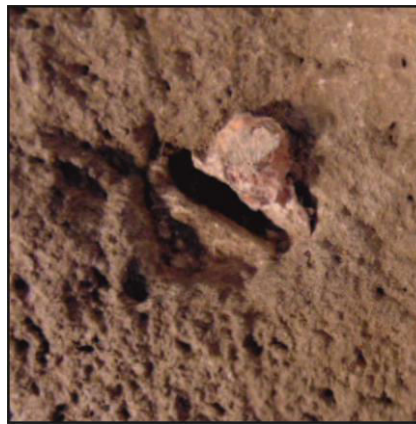
15b. ábra: Kengyel furat ólomkitöltéssel
