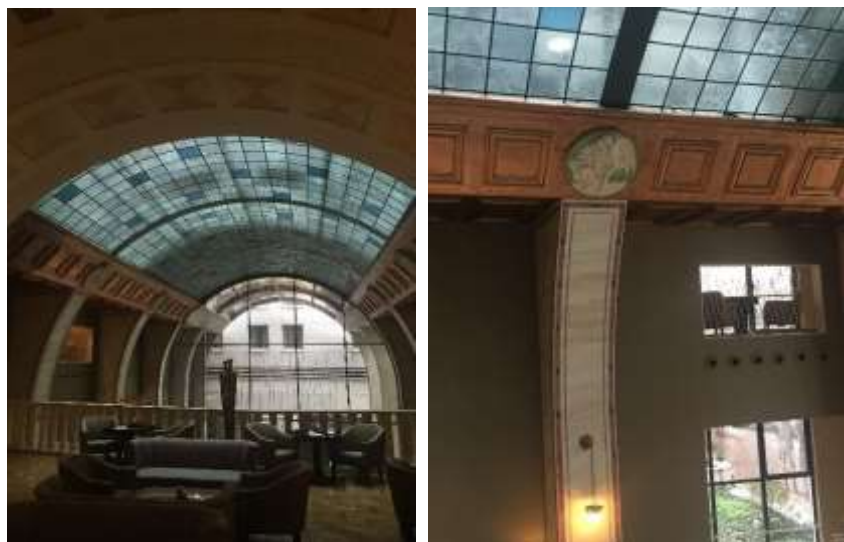
12. ábra: Uszodai tetőtér, Mozaik berakásos tartó oszlop
