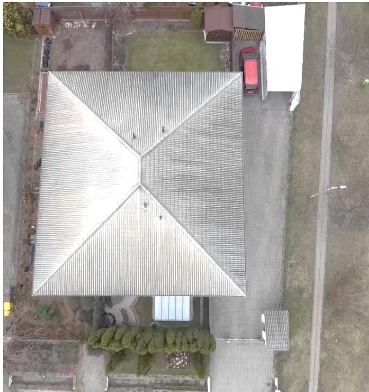
1. sz. kép: Felülnézeti kép a társasházról
