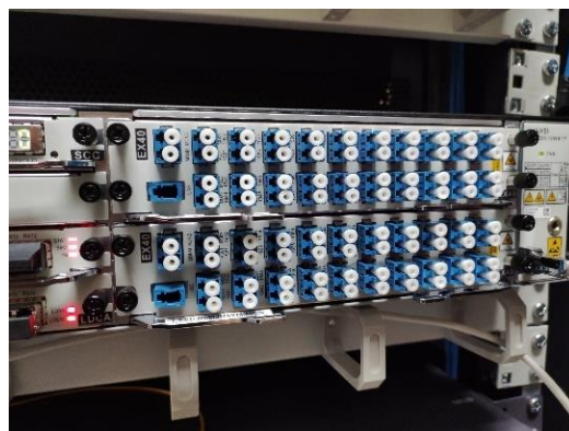
5.2 ábra: multiplexer és demultiplexer
